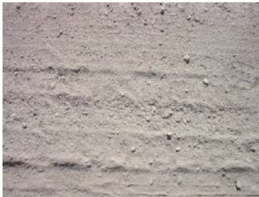
avant troisième application
