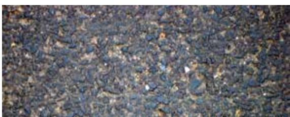
Superfície de alta qualidade após 32 anos em utilização sob trânsito em Colónia.
