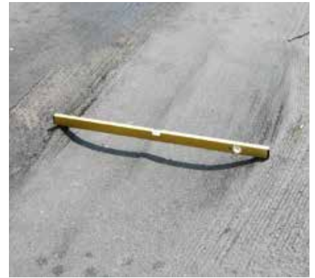
Spurbildung unter zunehmendem Schwerverkehr und erhöhten Achslasten
