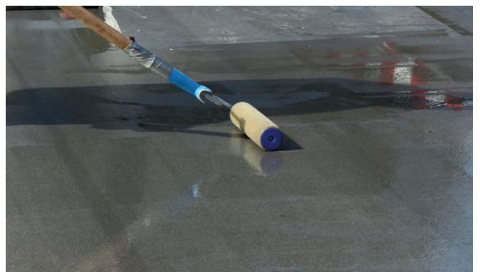
图9: 打底施工
