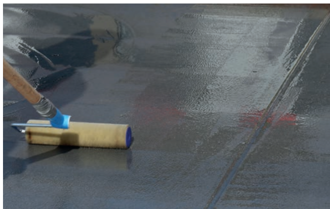
图2: 打底施工
