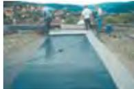
Verlegung und Verschweißung der neuen Dachabdichtungsbahnen
