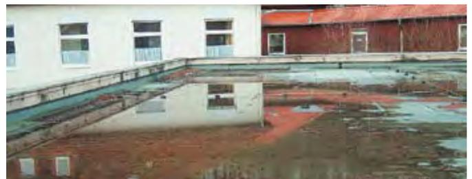
Vorher: Undichte Bitumendachfläche
