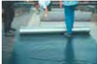
Trennlage auf alter Bitumenabdichtung
