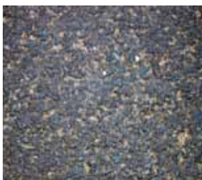
Surface de grande qualité après 32 années d'utilisation dans des conditions de circulation à Cologne.
