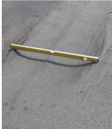
Ornières causées par le trafic de poids lourds et des charges d'essieu supérieures
