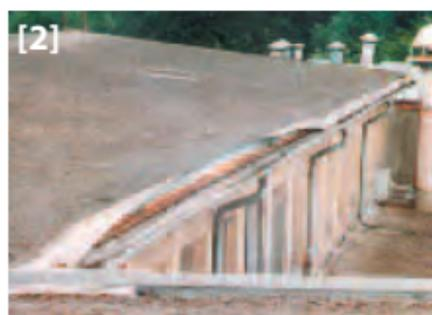
**Abbildungen: [1], [2] Kältekontraktionsschäden**
