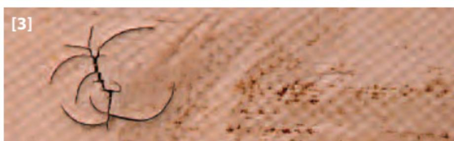
Abbildungen: [1] Hagelkörner; [2] & [3] Beschädigte Flachdachoberflächen
